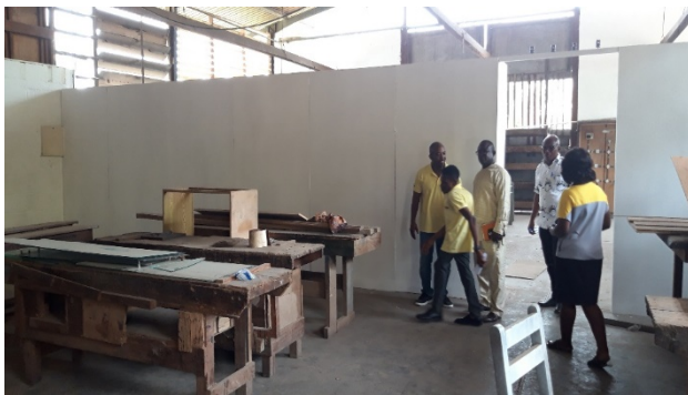
Die Werkhalle mit den neuen Trennwänden
